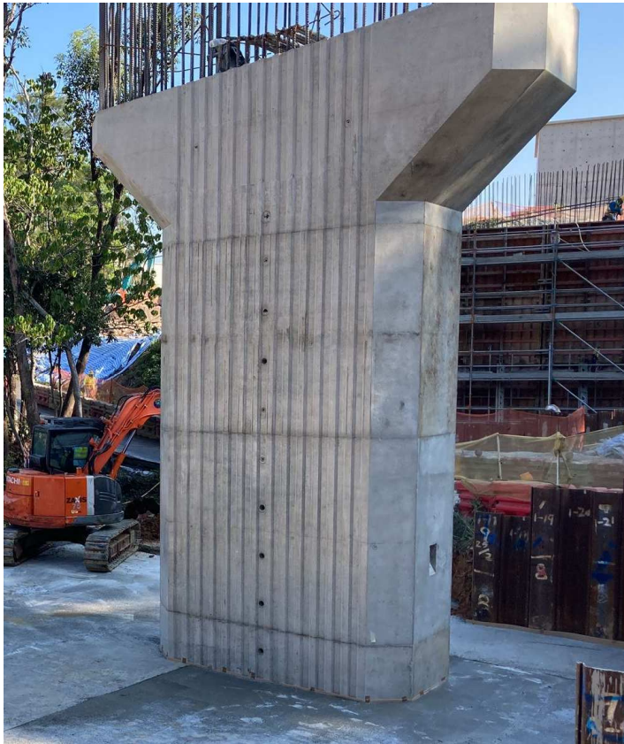
使用粒化高爐礦渣粉混凝土的橋墩 Bridge Pier adopted GGBS Concrete
