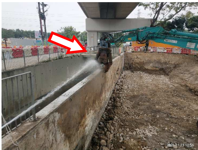
使用靜音機械 Use of quiet hydraulic breaker
